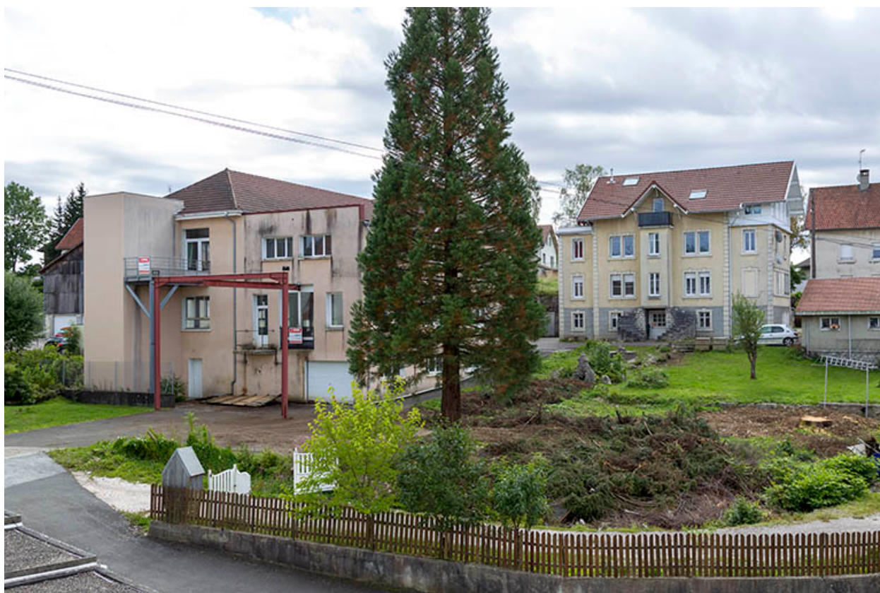
Vue d'ensemble, depuis le nord (façades postérieures).
