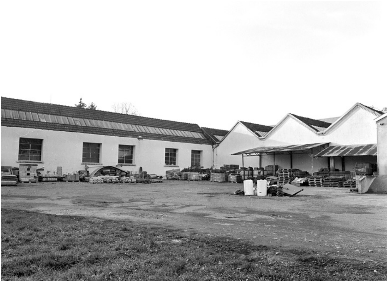
Façades arrière depuis la cour.
