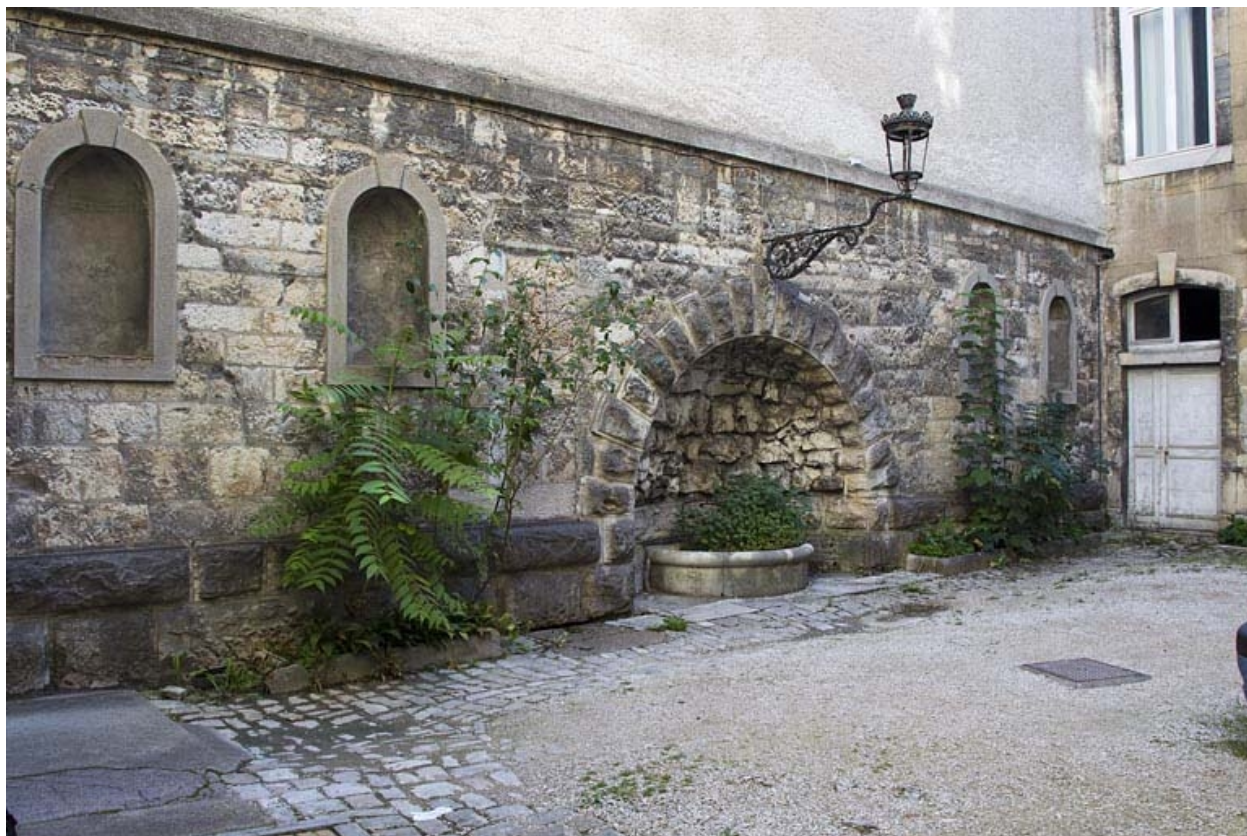
Mur gauche de la cour : vue d'ensemble.
