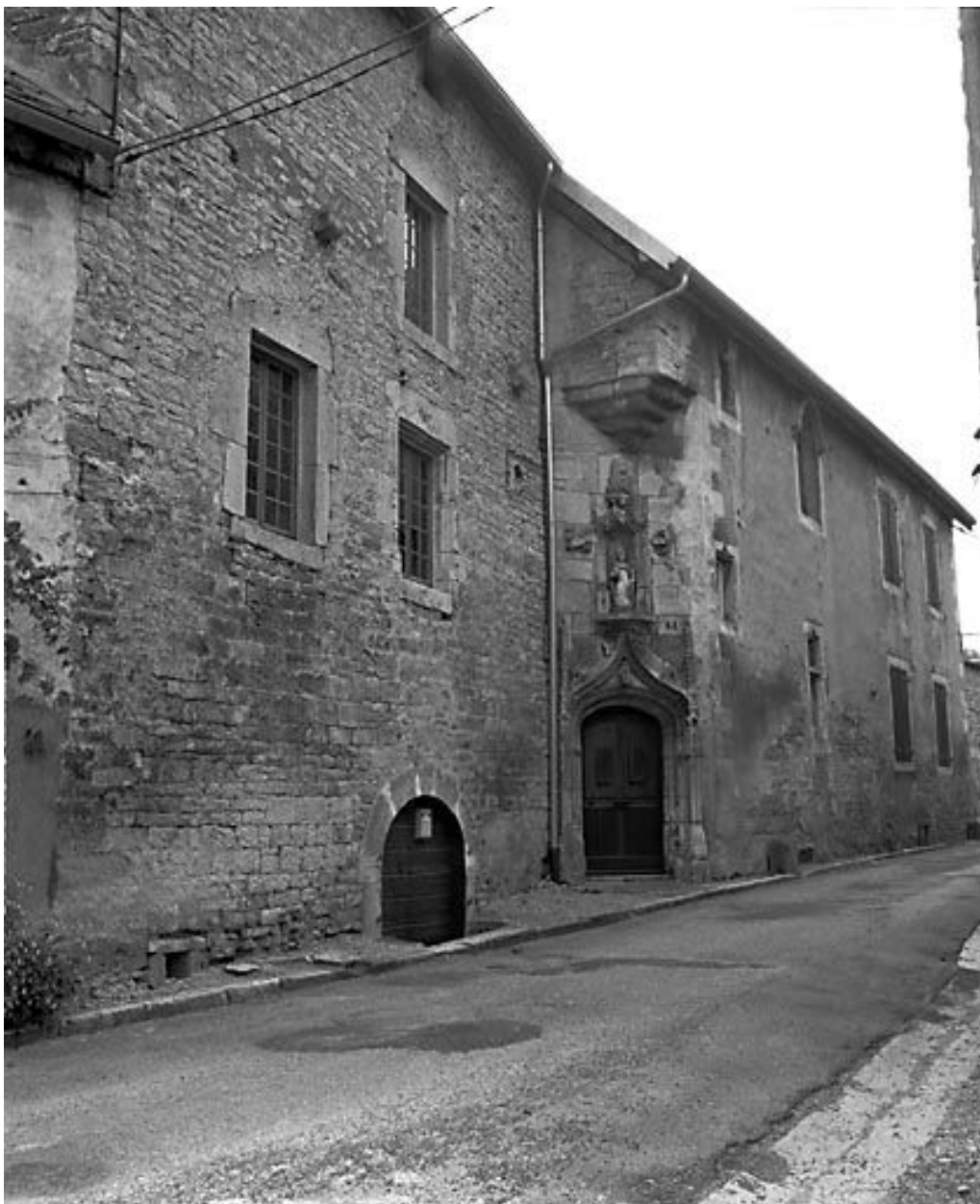
Maison de Balthazar Gérard située 3 rue Gérard.
