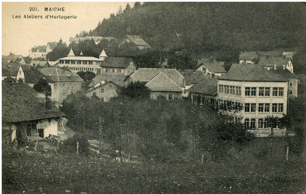
201. Maîche. Les ateliers d'horlogerie, entre 1914 et 1918.
