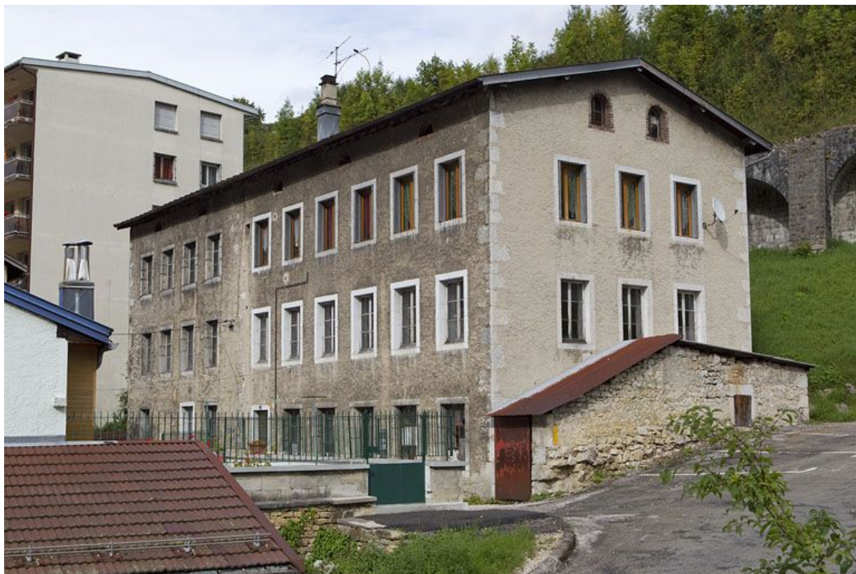
Façades antérieure et latérale droite.
