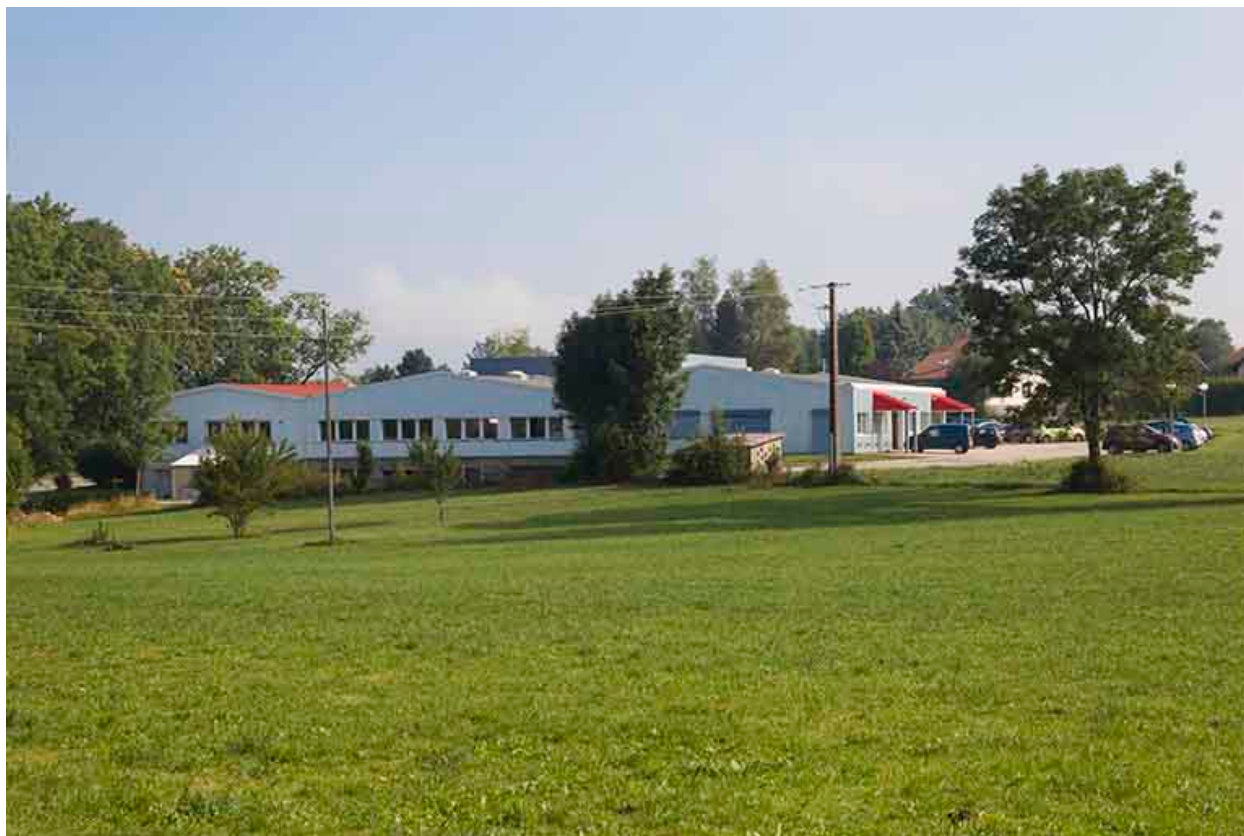
Façades postérieure et latérale gauche.
