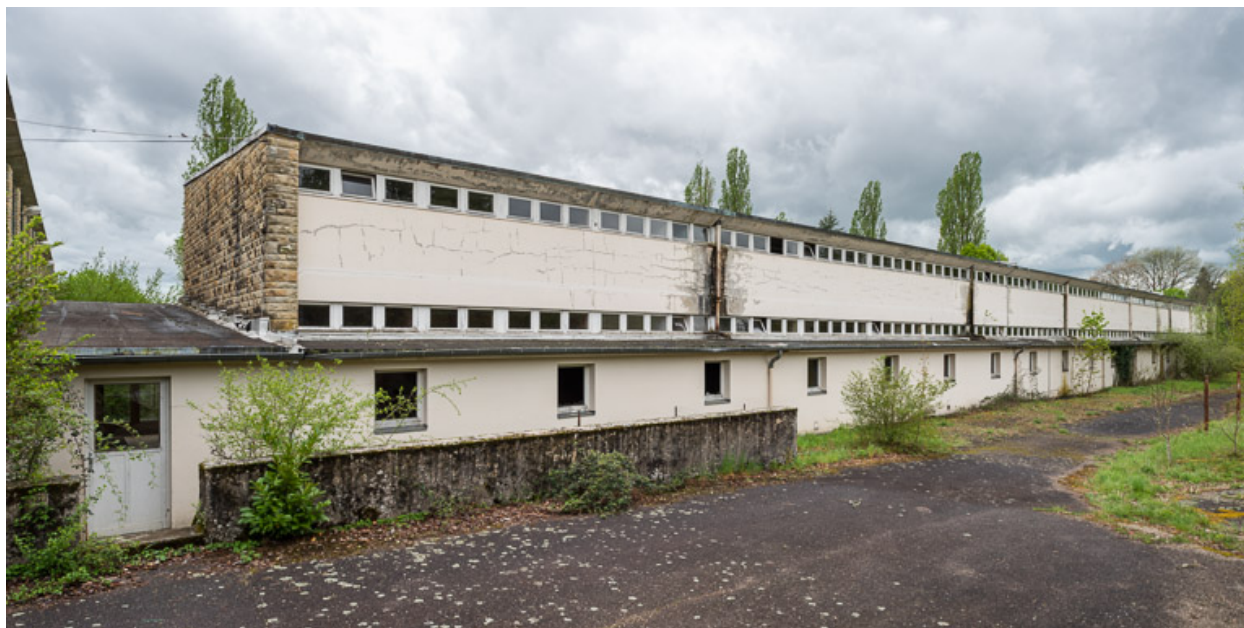
Élévation extérieure de l'aile Bellevue, côté nord.
