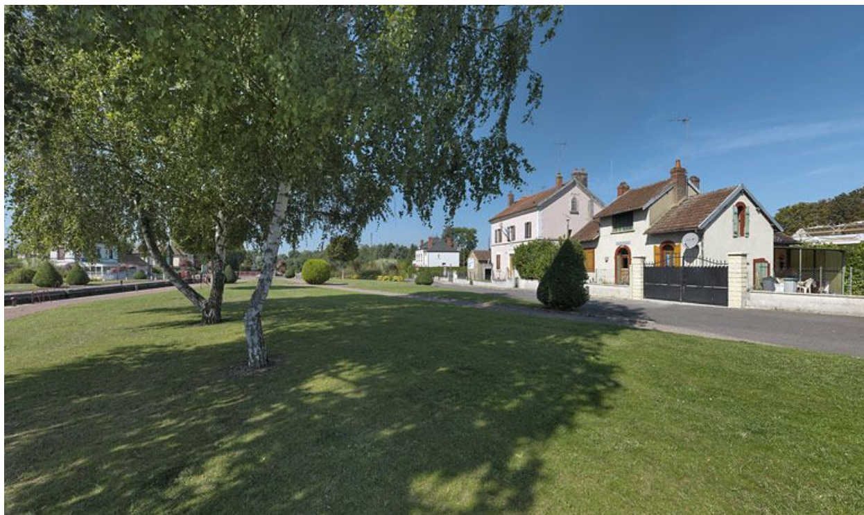
Site d'écluse vu d'aval.
