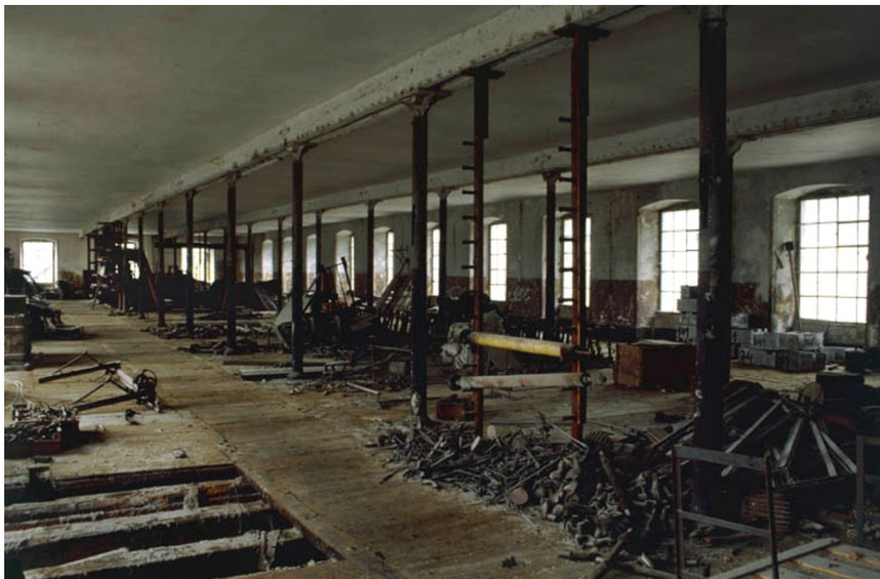
Salle de tissage du bâtiment à étages.
