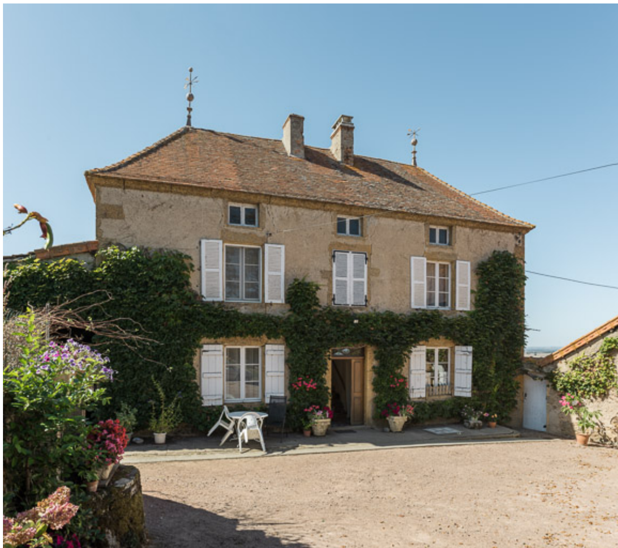
Façade antérieure de la maison
