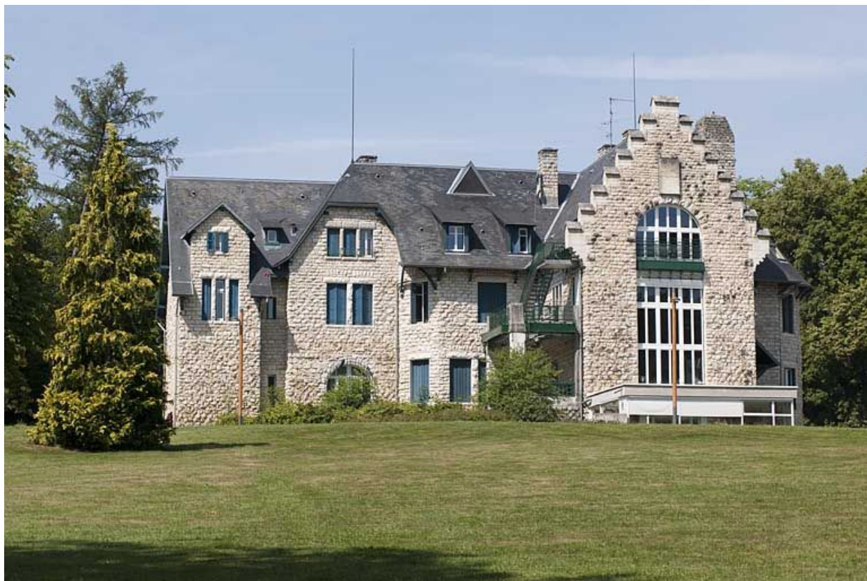
Façade postérieure depuis le sud-est.
