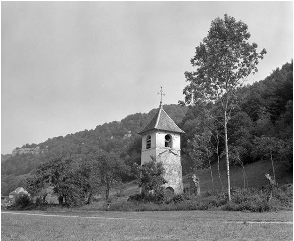
Tour du clocher depuis le sud-est.
