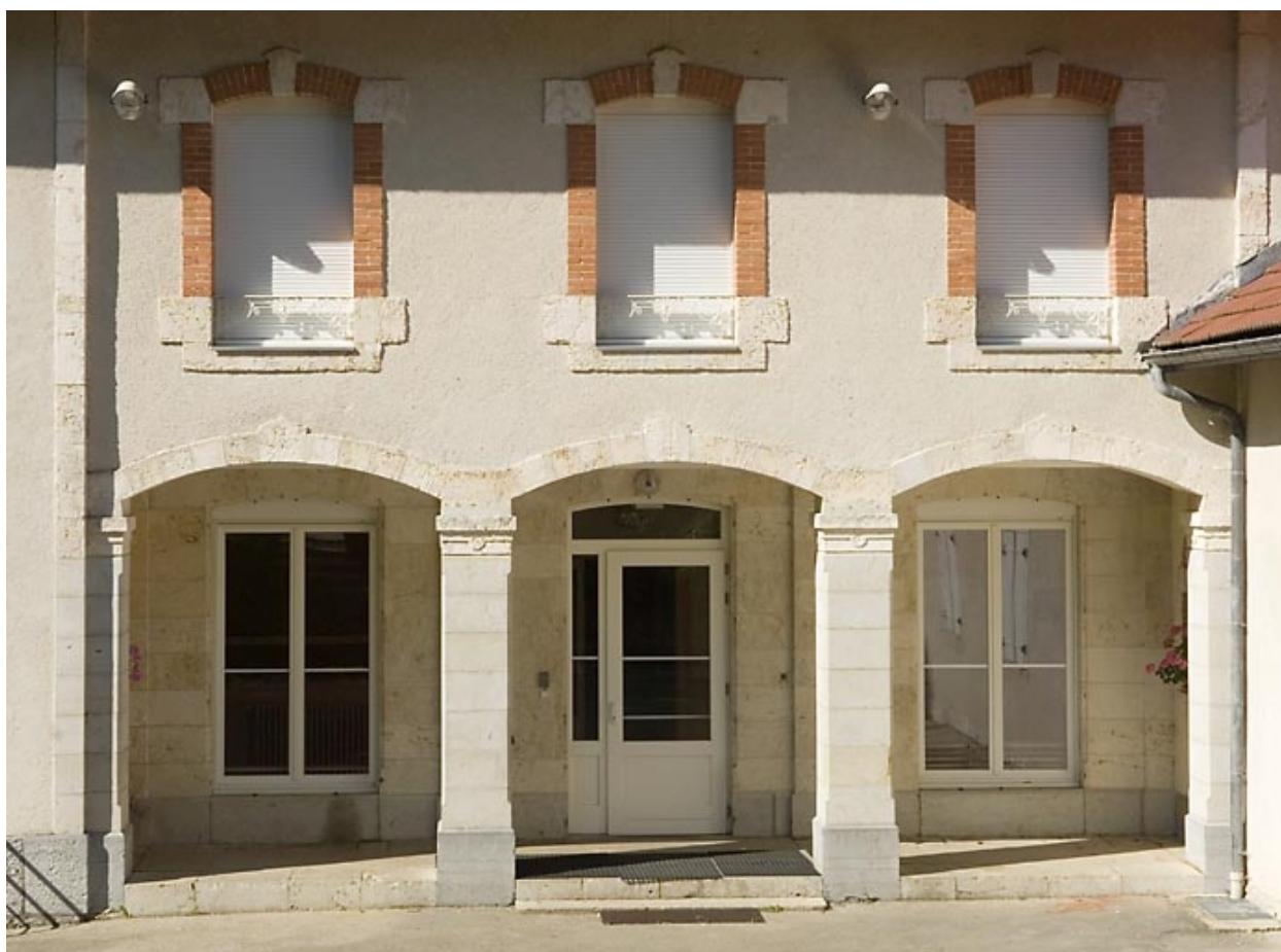
"Grand Château" : baies sur la façade antérieure.
