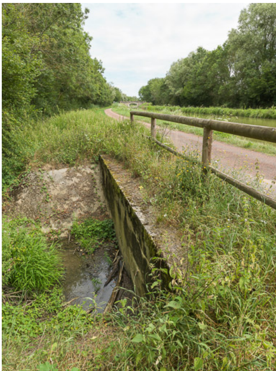
Vue de l'aqueduc.
