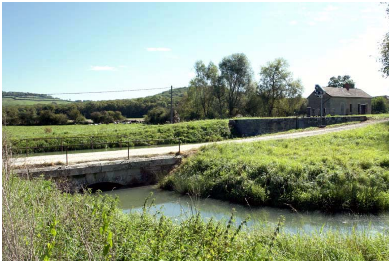
Passage de la rigole sous le chemin de halage.
