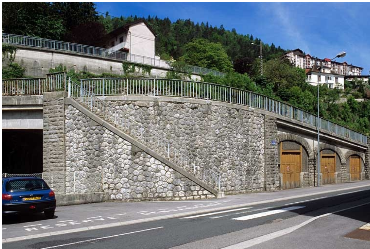
Escalier indépendant et rampe d'accès.
