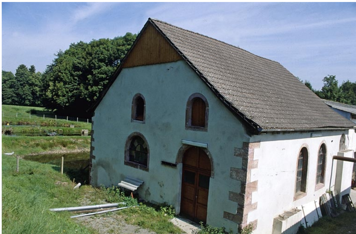
Salle des machines.
