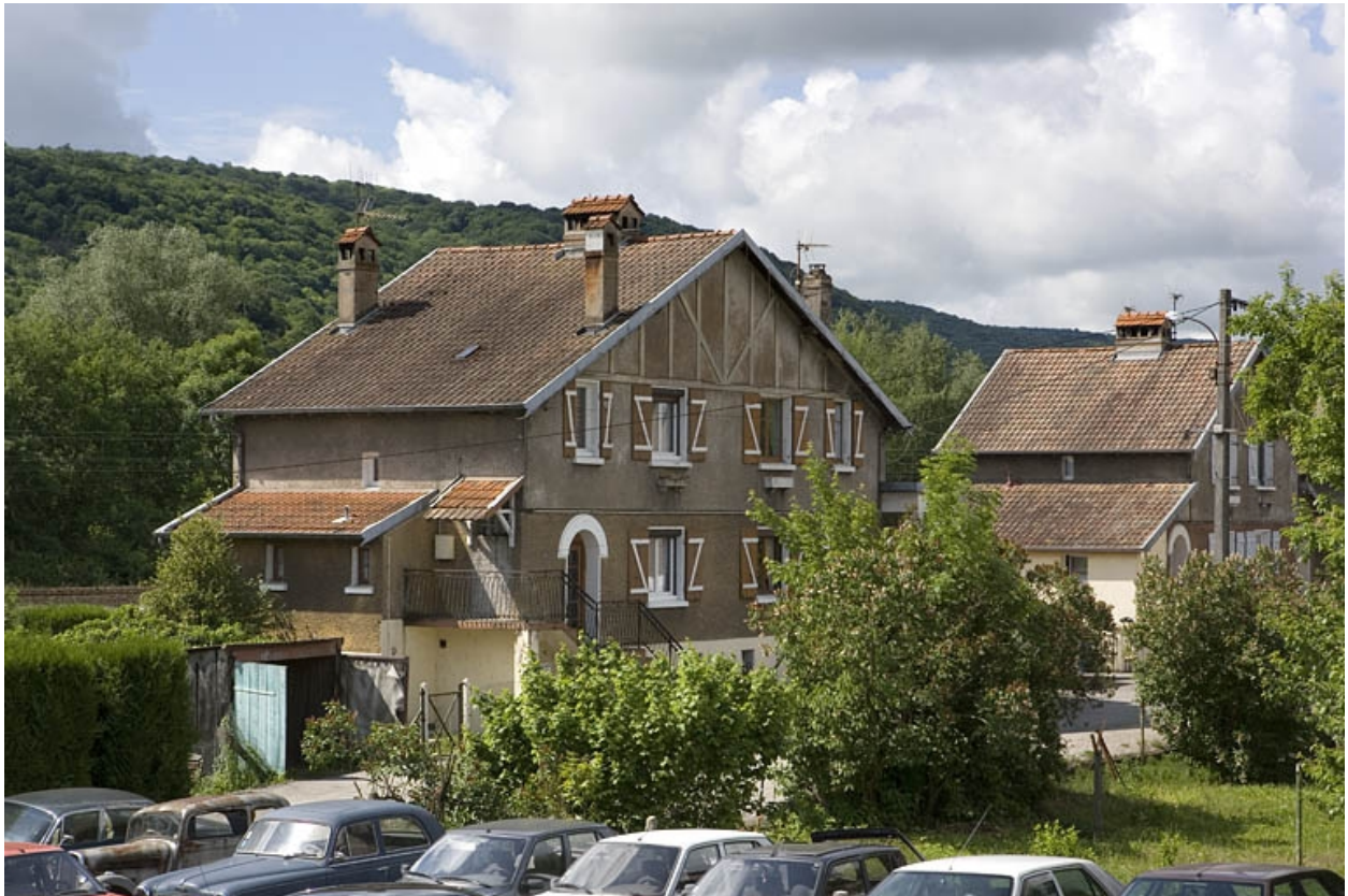
Place de Chemontey. Façade antérieure d'une maison.
