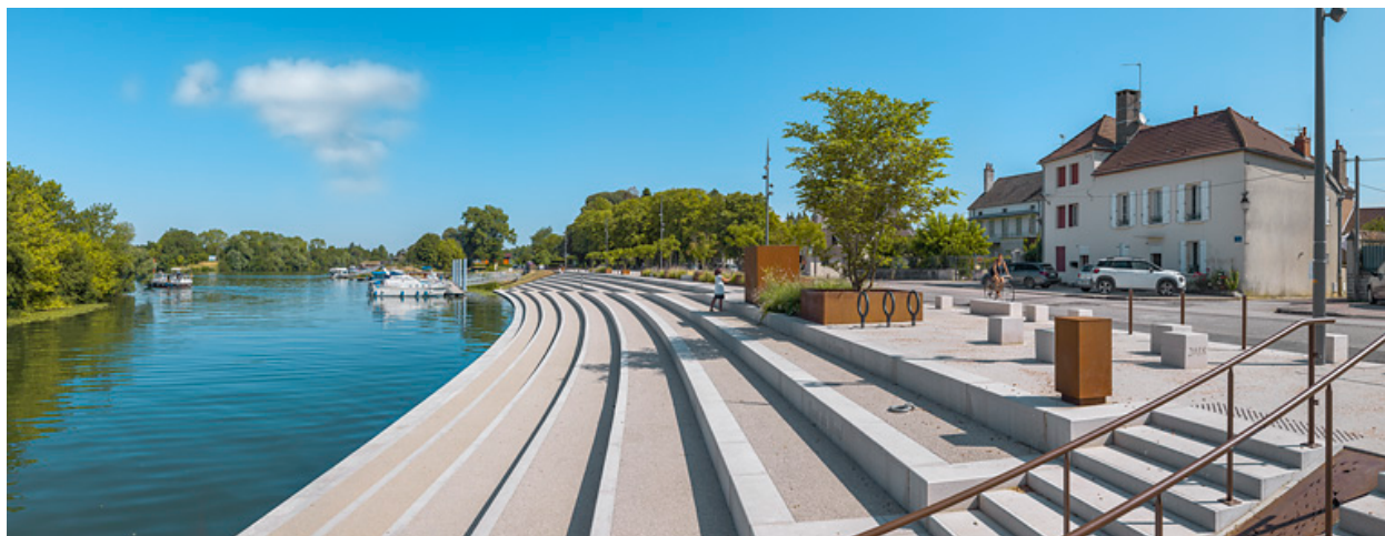
Vue d'ensemble des quais après leur réaménagement.
