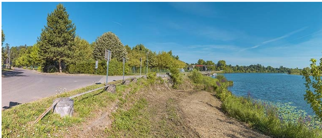
Perrés en aval du port de Gergy.
