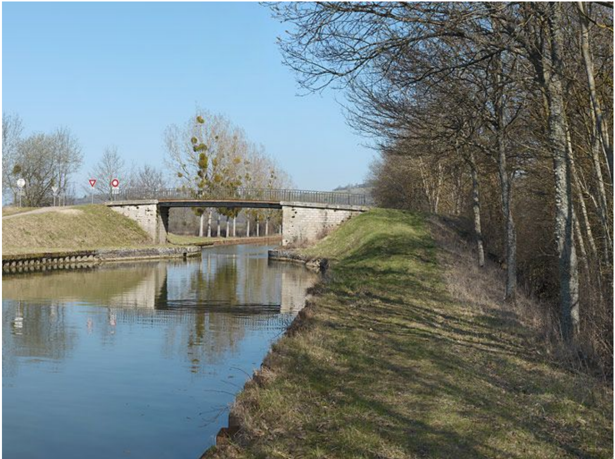
Le pont routier, vue d'ensemble.
