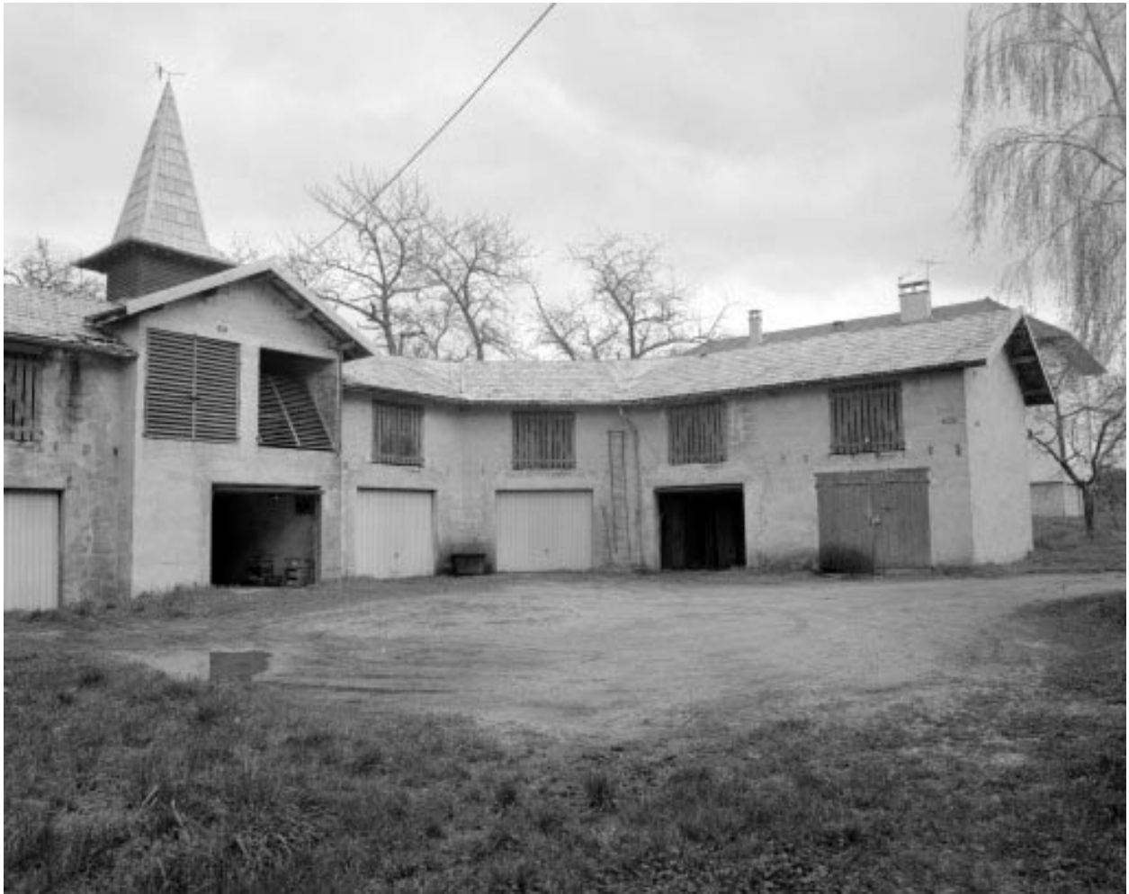
Remise d'automobile et bûcher (F) : cour.
