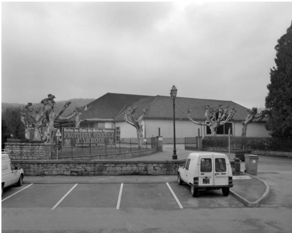
Vue d'ensemble de la nouvelle coopérative vinicole.
