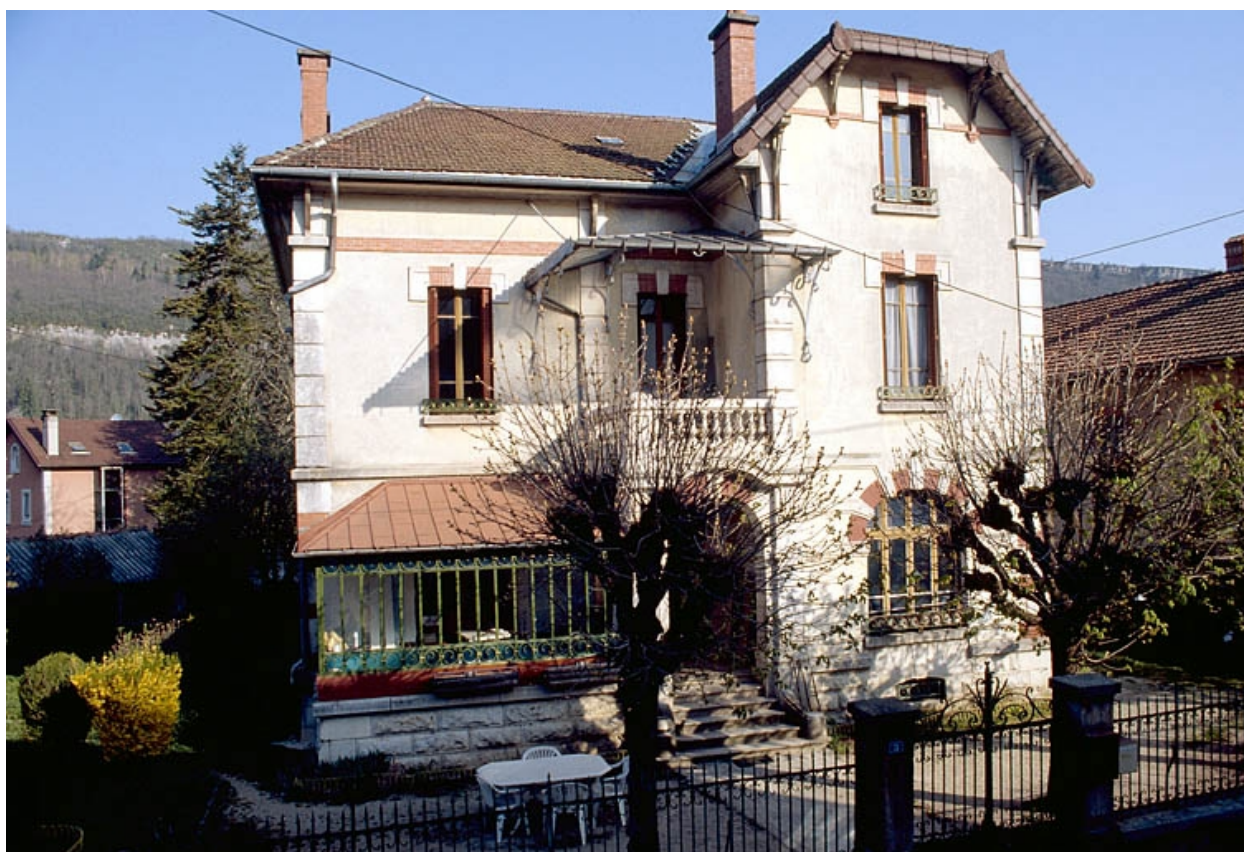
Maison d'industriel à Molinges : façade antérieure.
