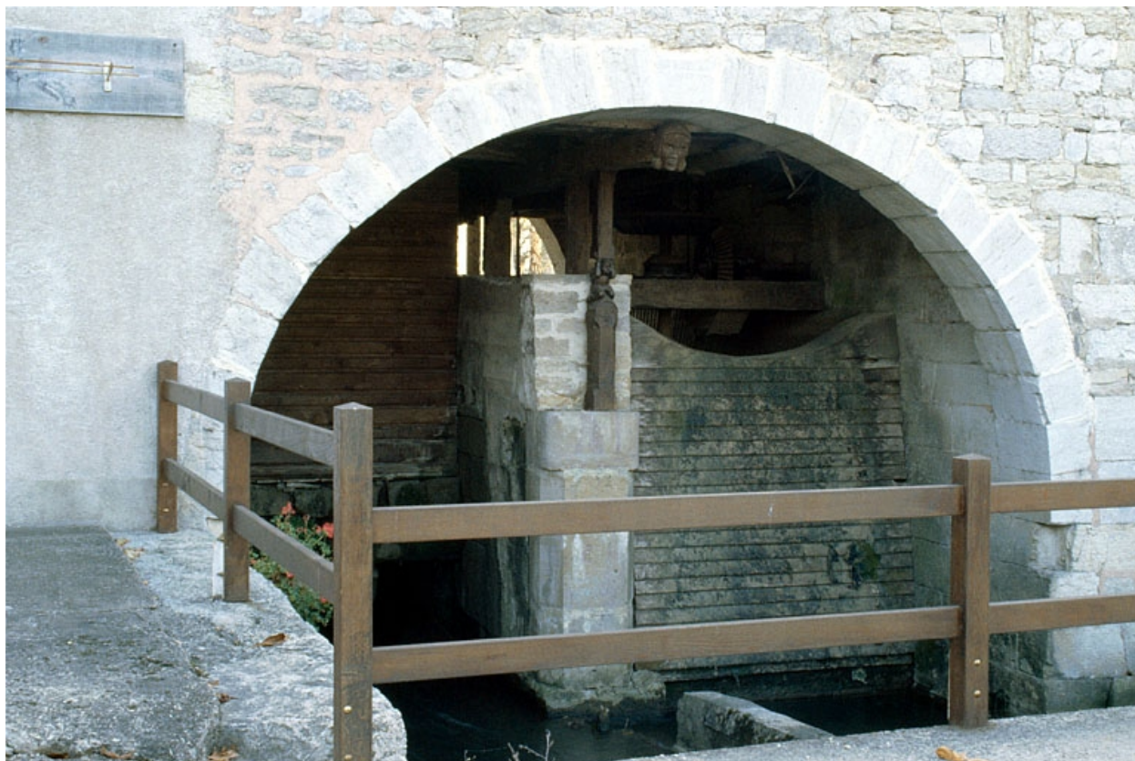
Chambre d'eau de la turbine, depuis l'aval.
