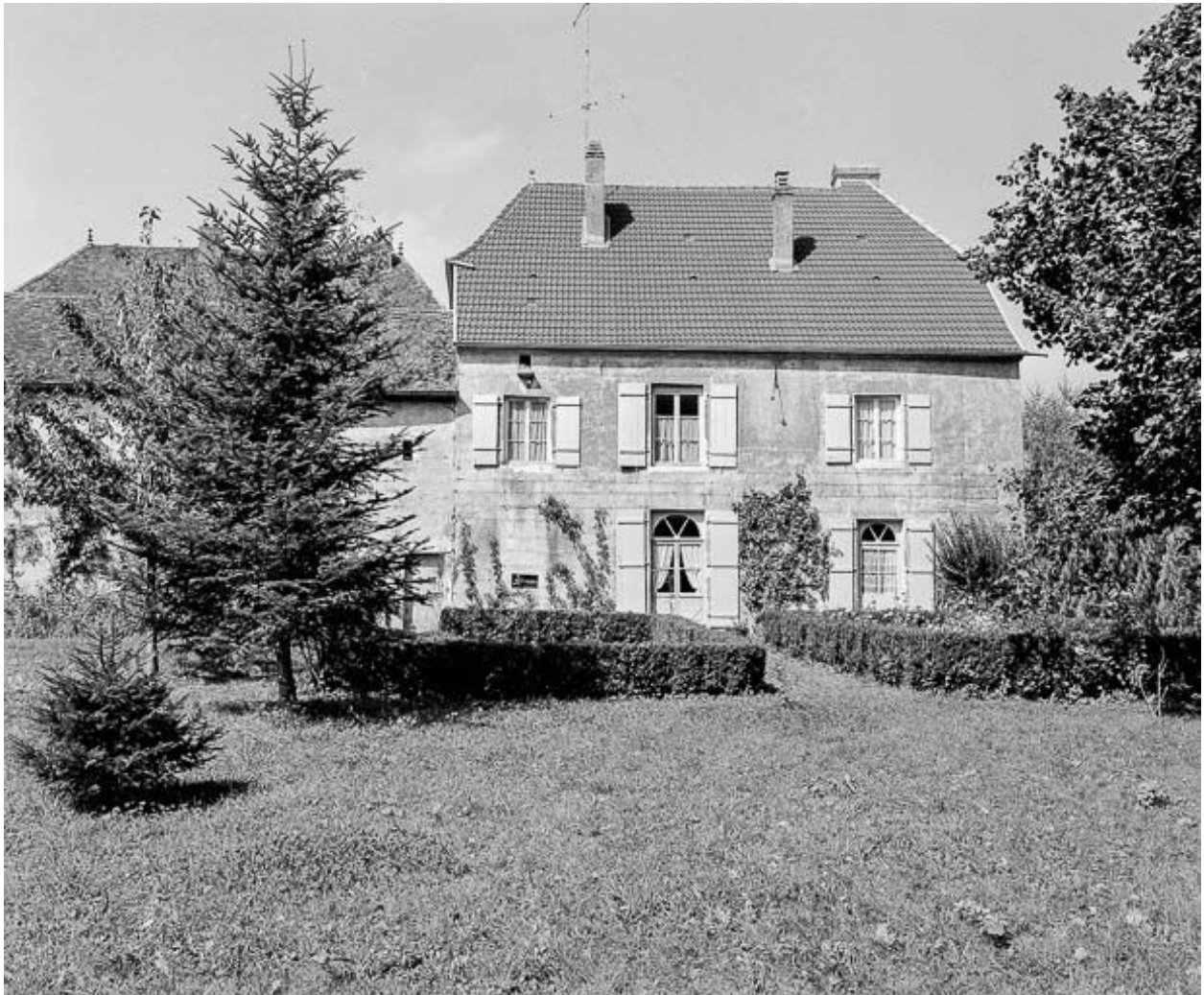
Façade postérieure de l'habitation.
