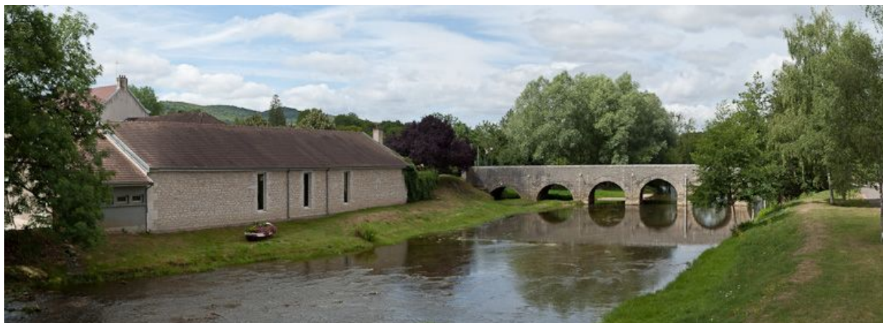
Vue du pont ancien sur l'Ouche.
