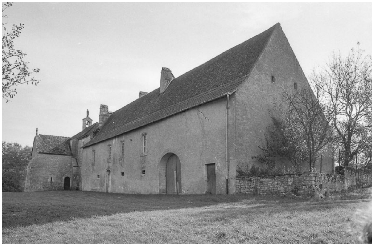
Bâtiment annexe, façade antérieure.
