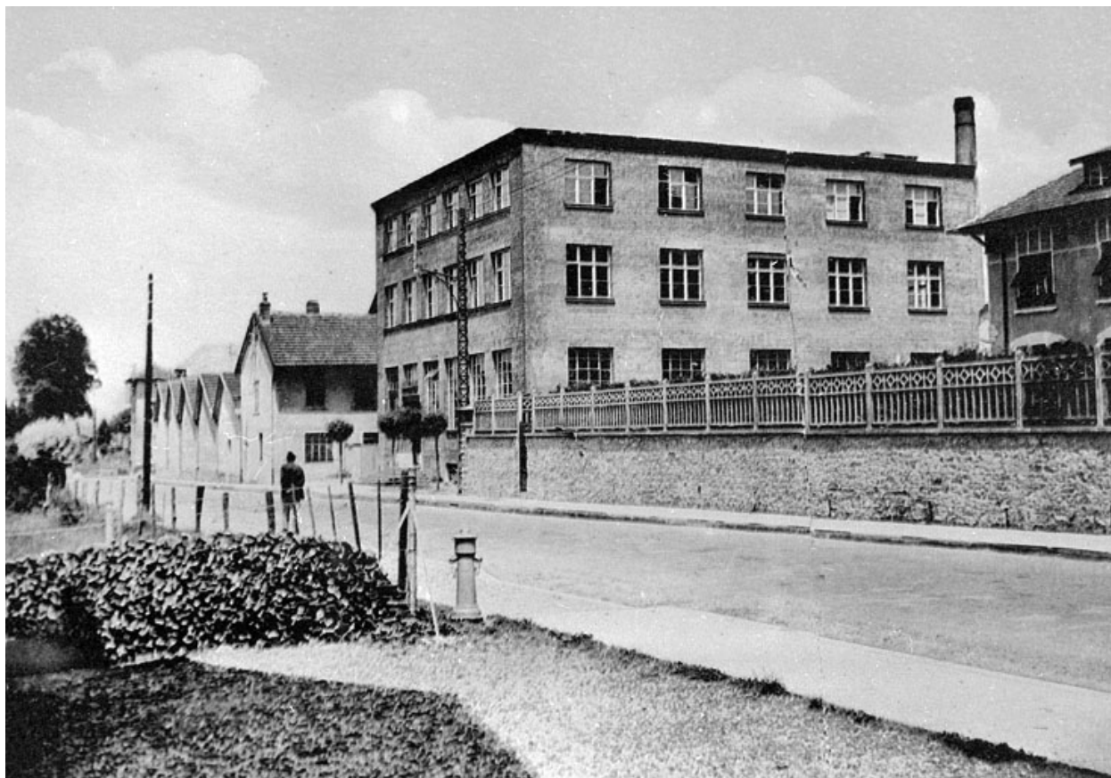
Delle. - Usine Société Industrielle.
