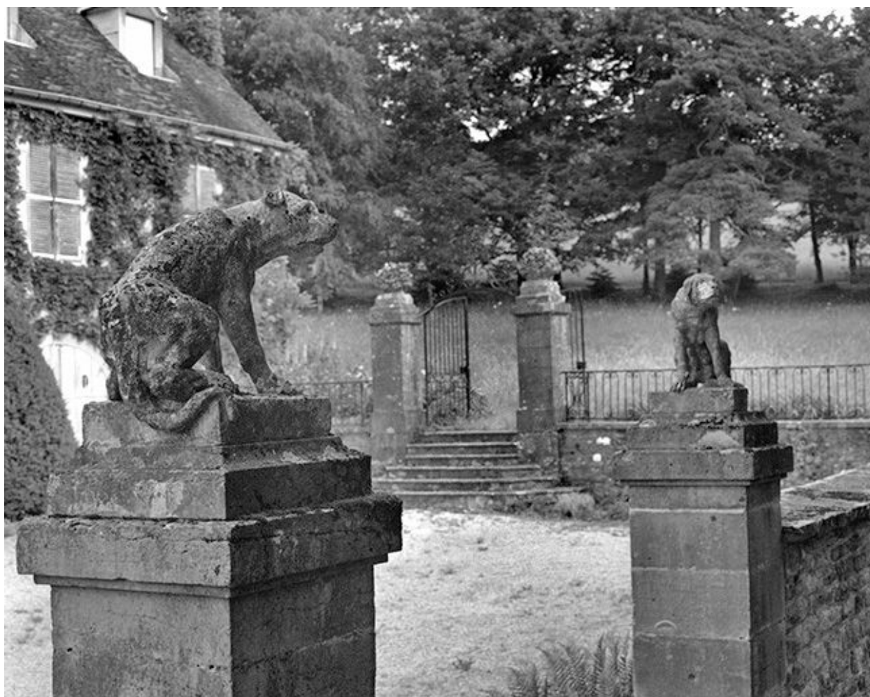
Portail d'entrée : partie supérieure.
