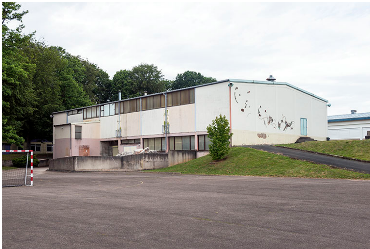
Atelier de gros oeuvre : vue trois-quart.
