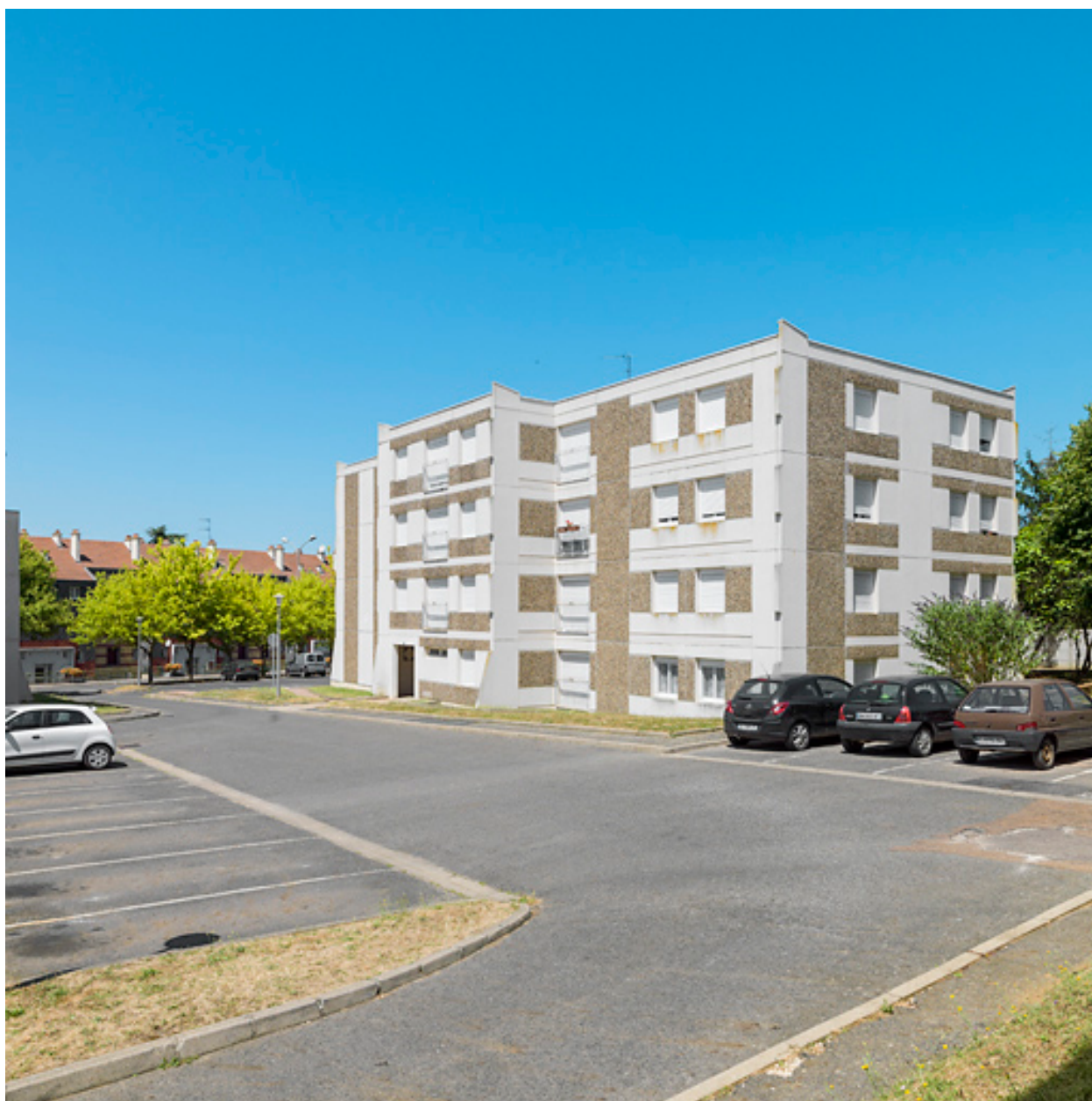
Bâtiment 26, façades antérieure et latérale.
