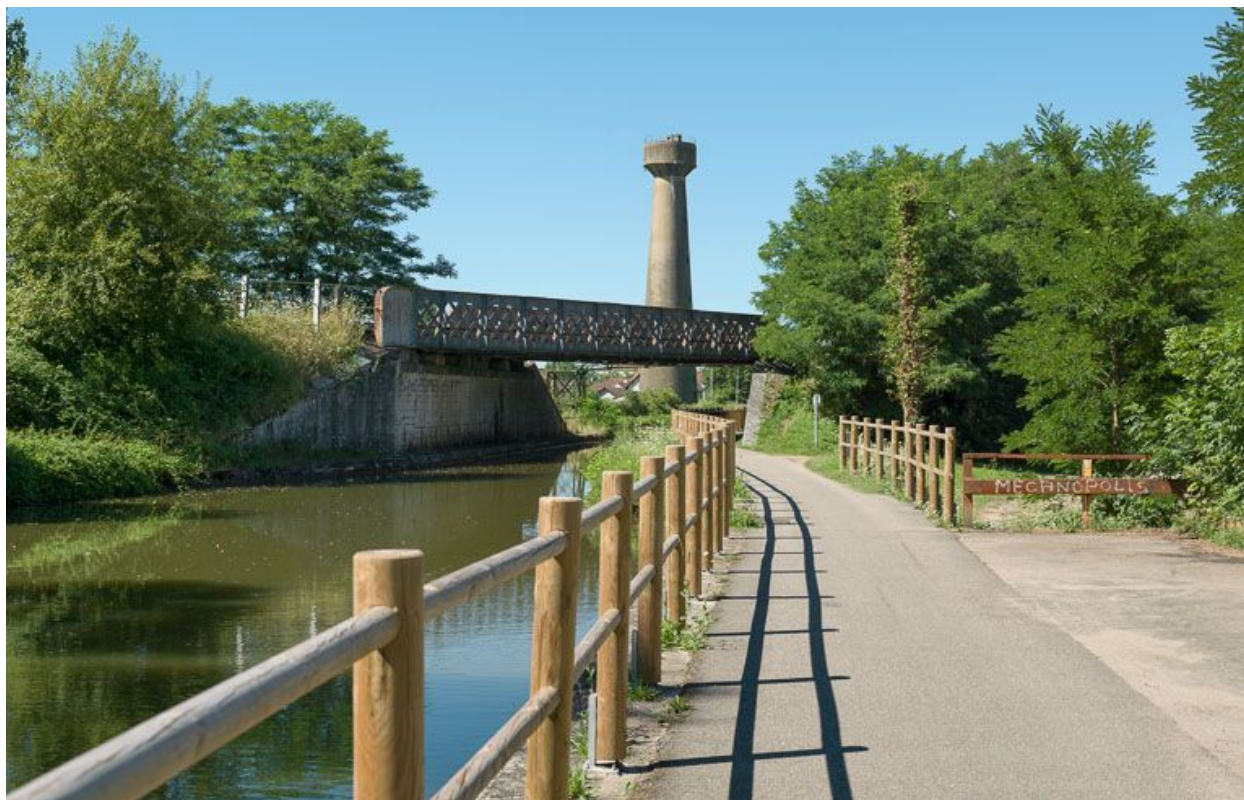
Le pont ferroviaire vu d'amont.
