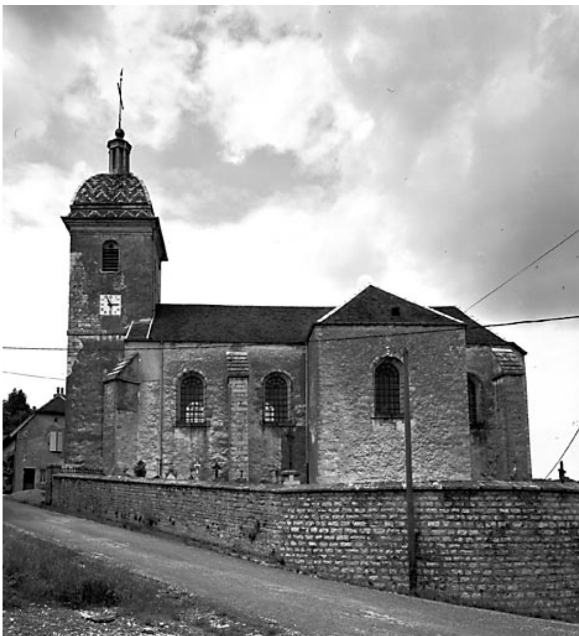
Façade latérale sud.
