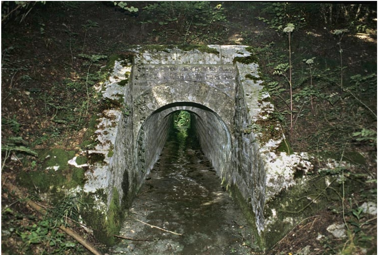
Tête amont (avec éclairage au flash).
