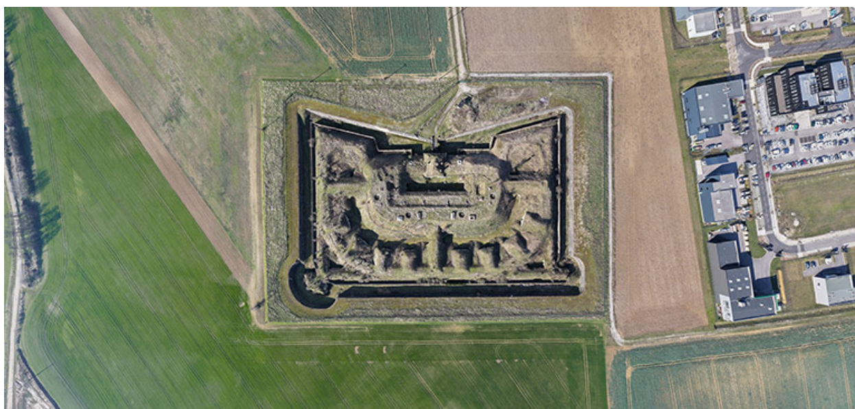
Le fort, vue d'ensemble. (vue aérienne).
