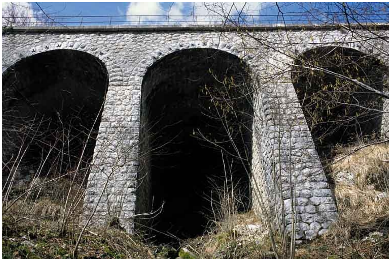
Mur de soutènement de la route : arcades.
