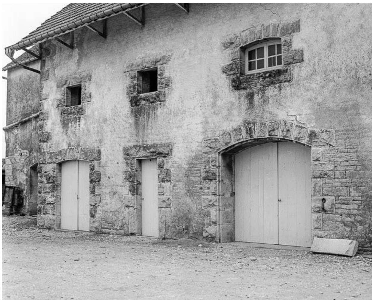
Partie agricole : détail de la façade postérieure.
