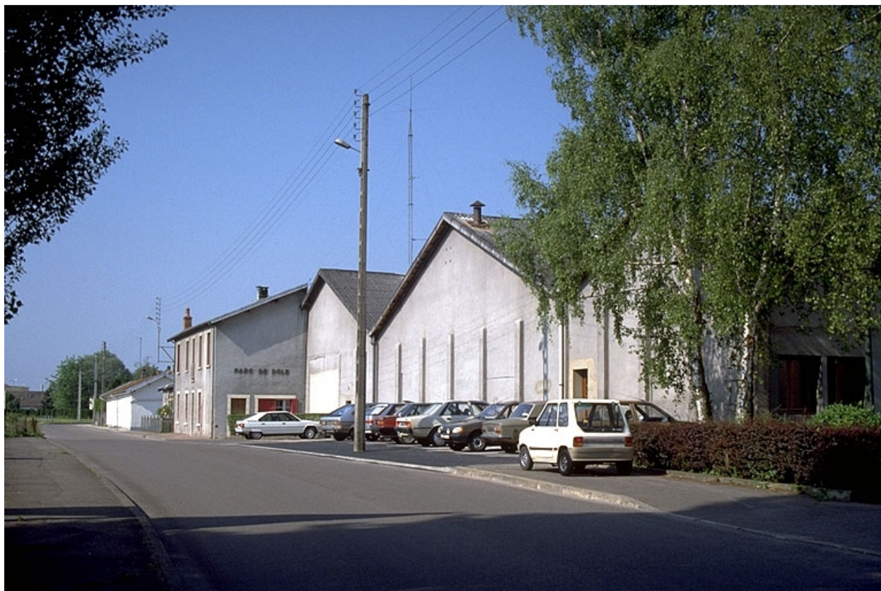
Façade antérieure vue de l'est.
