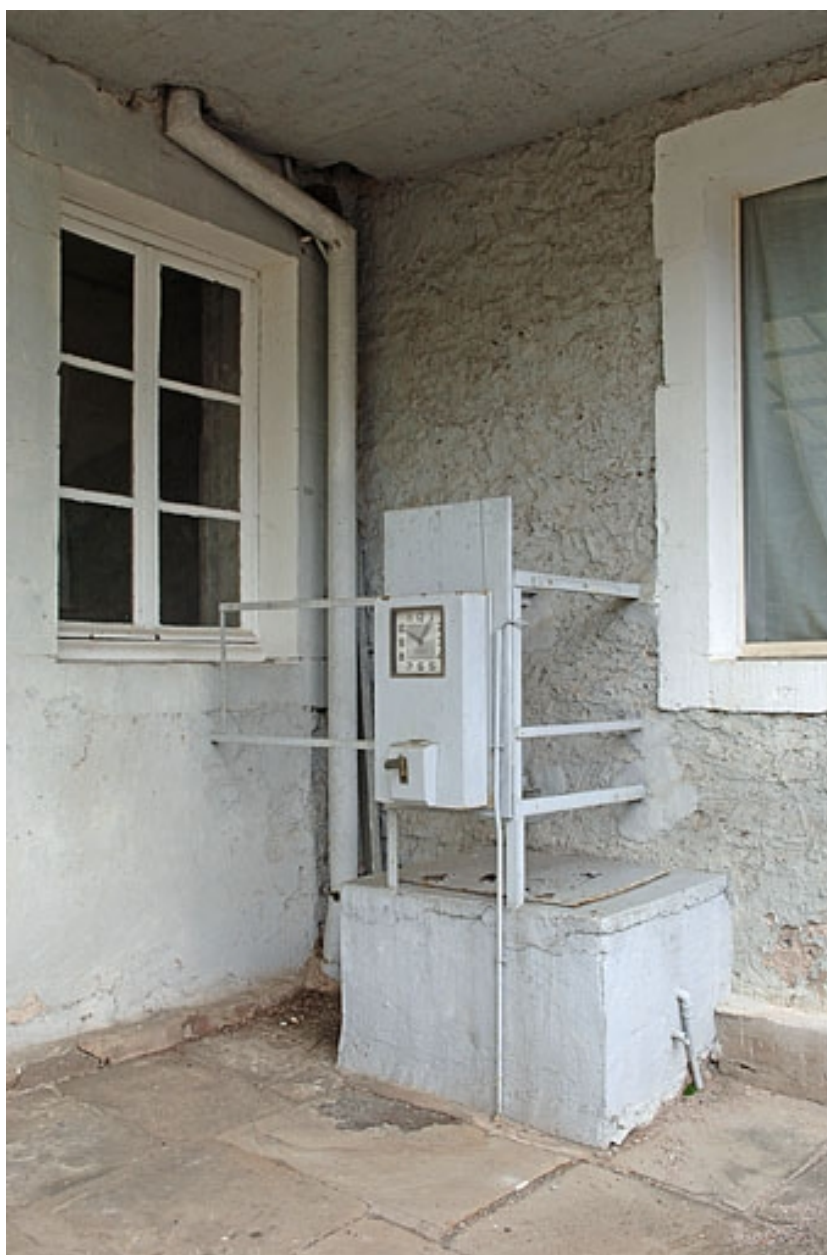
Entrée des bureaux et appareil de pointage.
