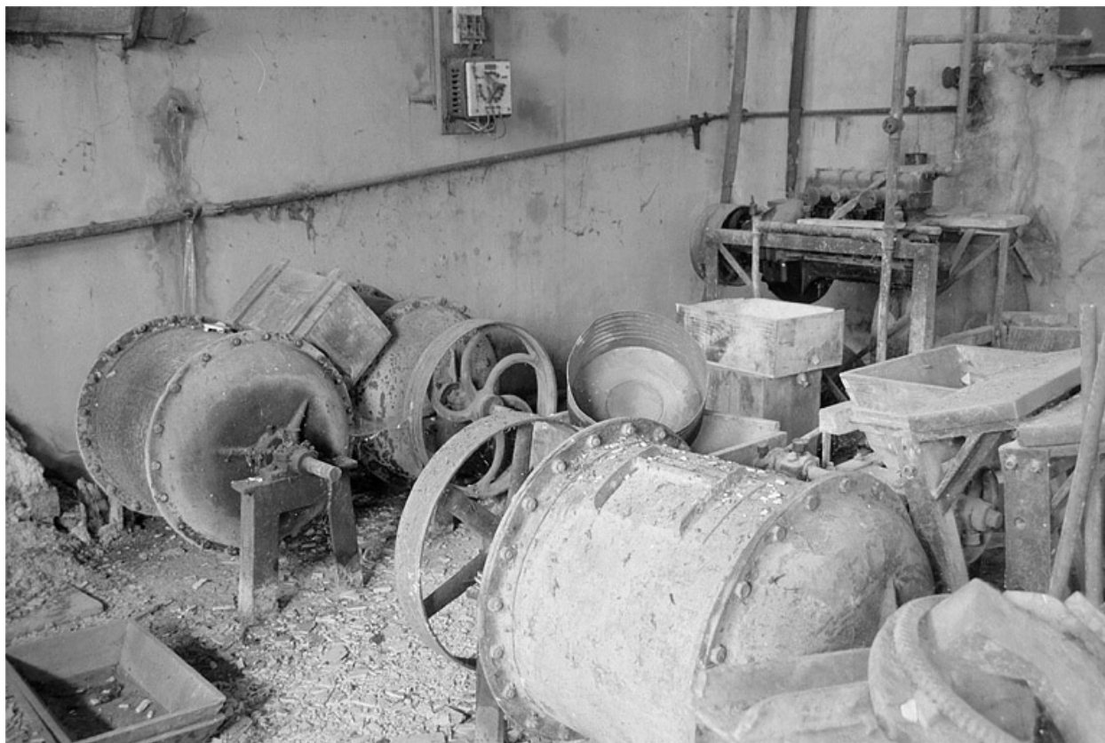
Moteurs électriques des équipes.
