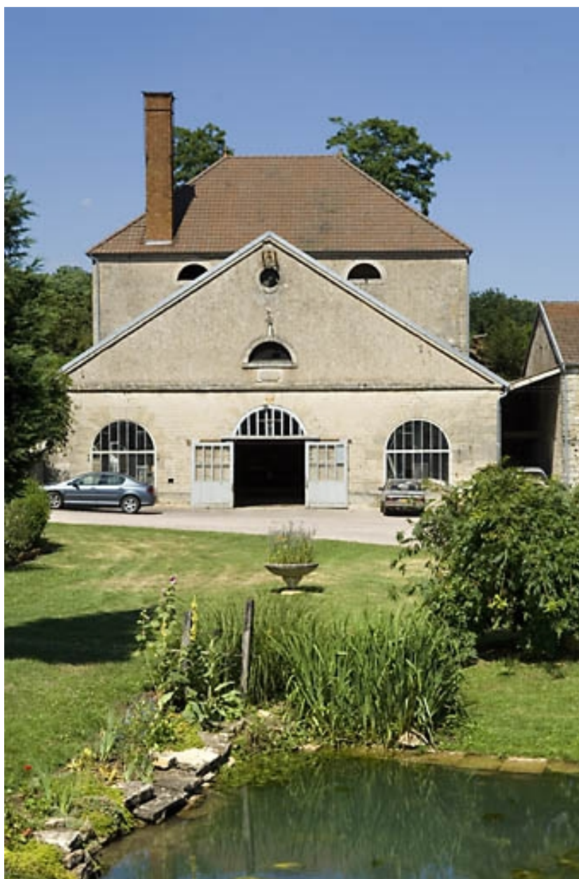
Le haut fourneau vu de face.
