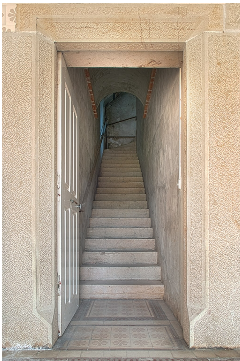
Corps central, escalier du comble.
