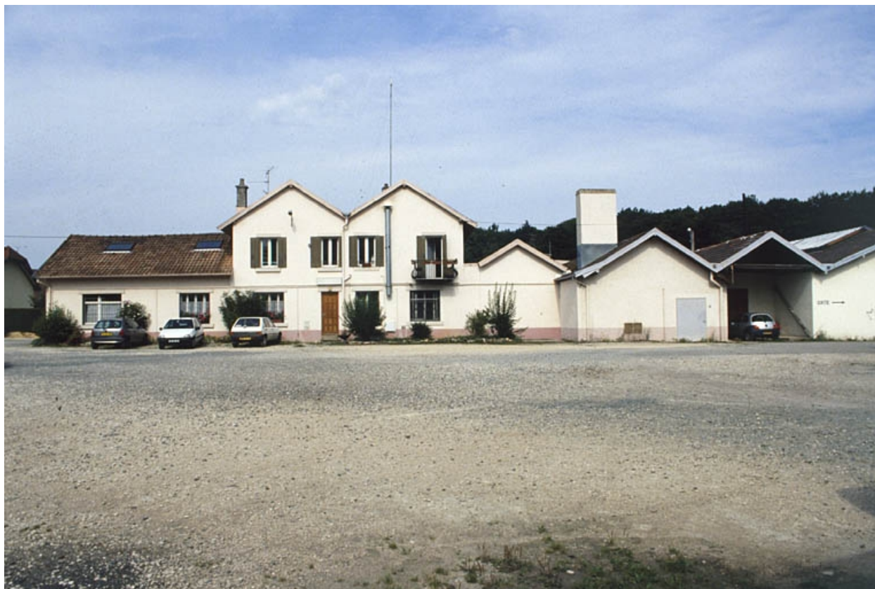
Façade postérieure des bâtiments sur rue.
