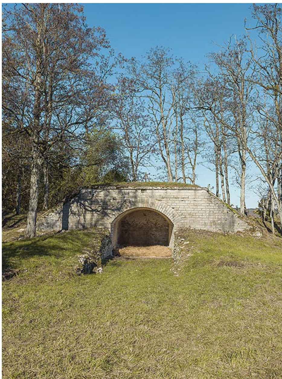
Traverse-abri de la batterie.
