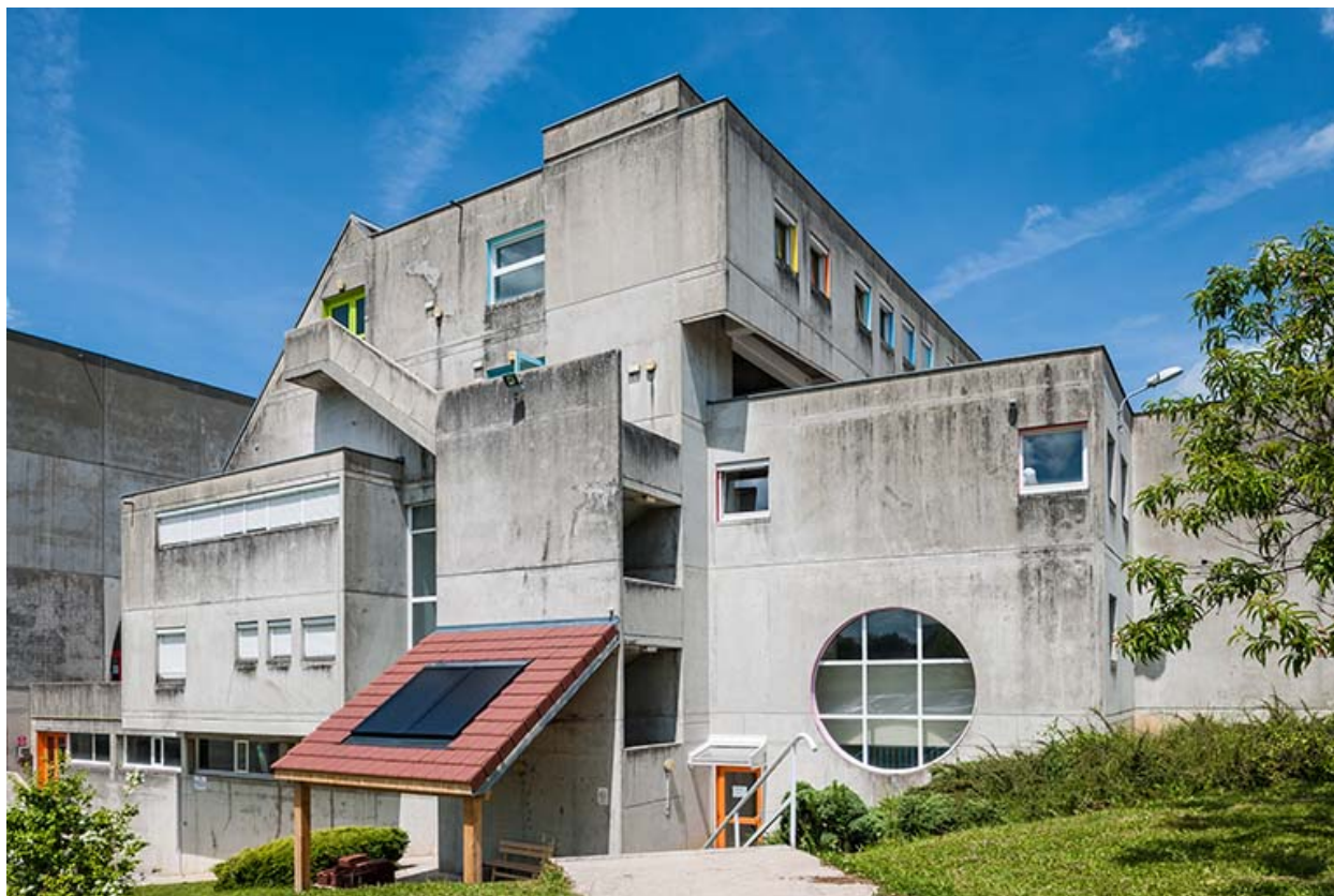
Pignon du bâtiment
