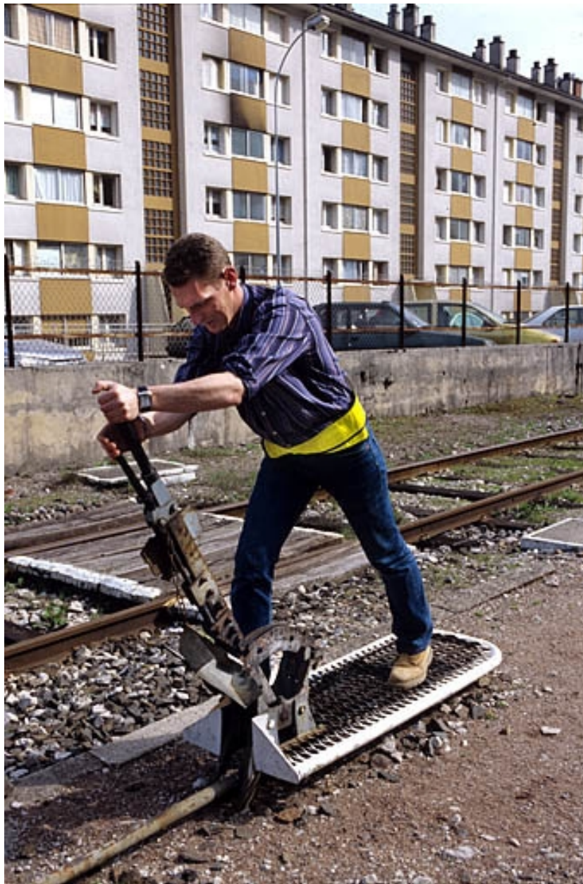
Garage d'un autorail X 73500 sur la voie 11 : manoeuvre de l'appareil de voie C par un agent.
