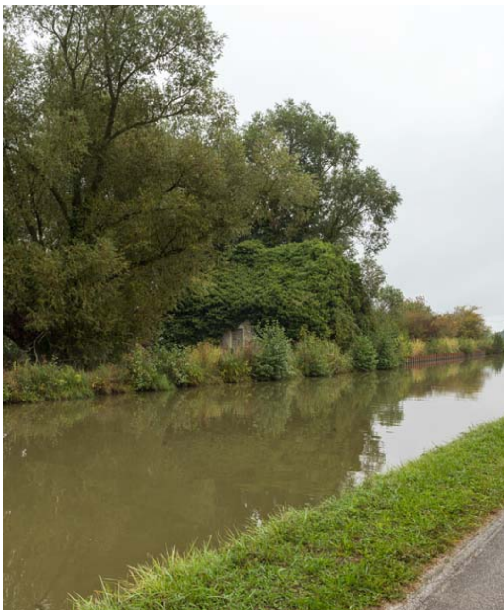
Ancienne maison éclusière, envahie par la végétation.
