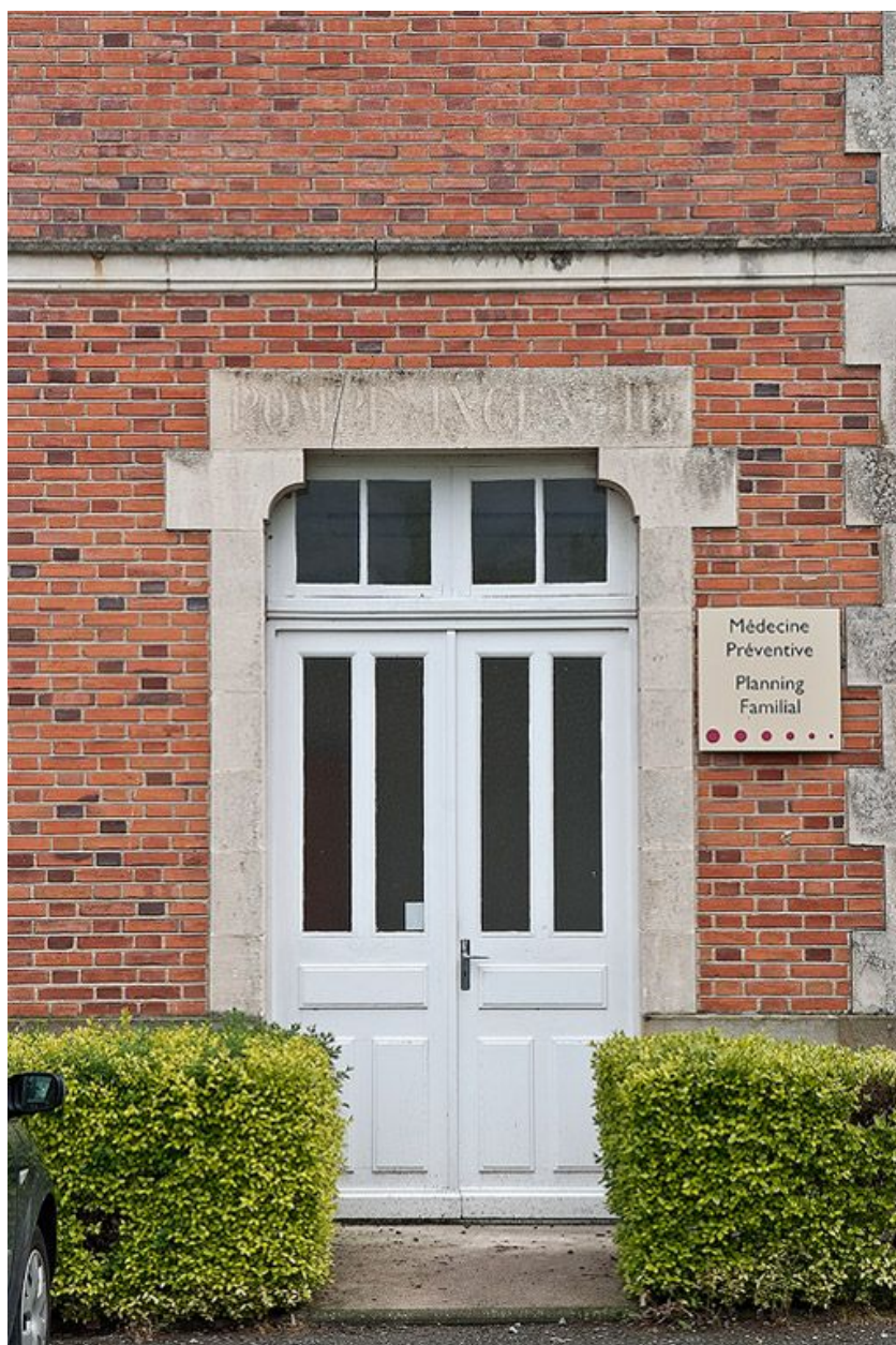
Bâtiment de services : porte latérale.
